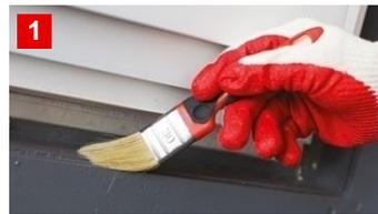
1 Очистите поверхность при помощи мягкой щетки или кисти. Для удаления жировых загрязнений используйте ветошь, смоченную очистителем монтажной пены ТЕХНОКОЛЬ.
