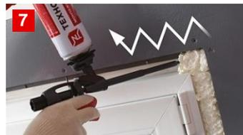
7 Заполняйте швы равномерными W-образными движениями, оставляя для расширения пены примерно 1/3 объема заправляемой полости.
