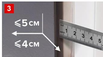
Размер заправляемой полости должен быть не более 4 см в ширину и 5 см в глубину. Большие полости заполняют в несколько приемов с интервалом в 10 – 15 минут.
