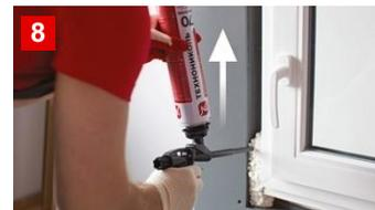
8 При заполнении вертикальных щелей пену наносят снизу вверх (в таком случае еще жидкой пене будет на чем держаться).
