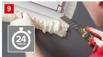
9 Процесс полной полимеризации пены составляет 24 часа. После этого удалите излишки пены и установите откосы.
