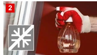
2 Рекомендуется увлажнить поверхность водой для улучшения сцепления пены. Пену нельзя наносить на поверхность, покрытую инеем или льдом!
